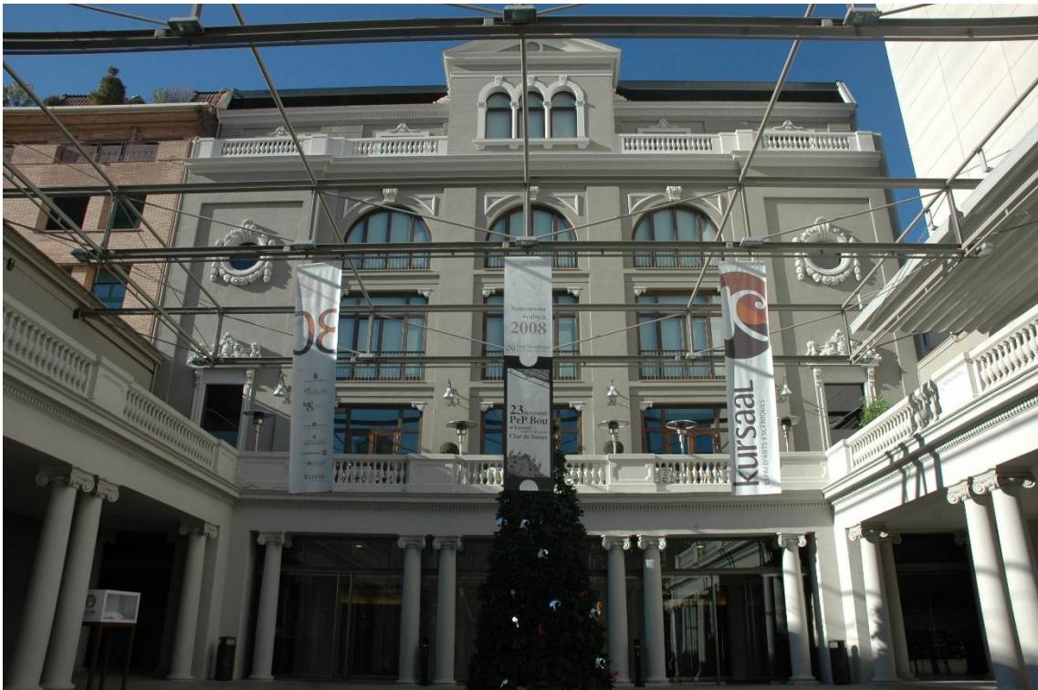
Fotografia de la façana del Kursaal - Espai d'arts escèniques Manresa
