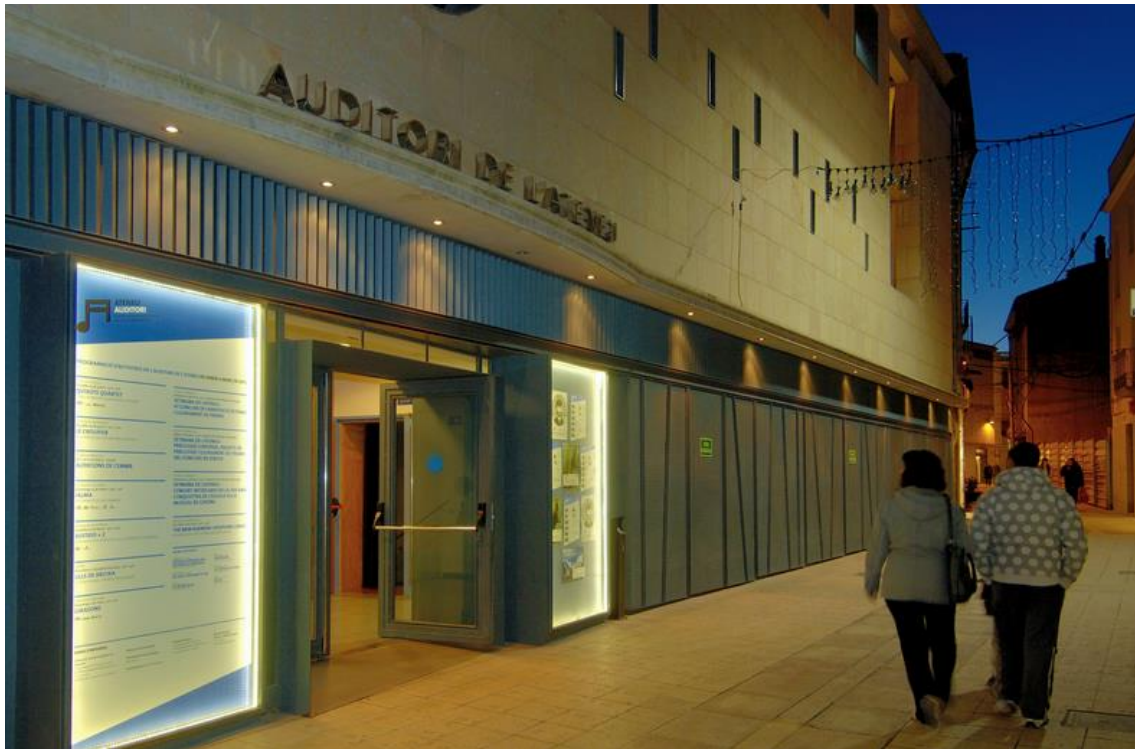
Fotografía de la fachada de l Auditorio Ateneu de Banyoles
